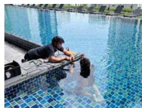
ซ่อมแซมส่วนต่างๆภายใน โครงการ - เปลี่ยนหลอดไฟสระว่ายน้ำ และ ทำกันซึมลาดฟ้าป้องกันน้ำรั่ว
